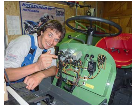
Strippenzieher: Den Kabelbaum hat Meister Horn nach ordentlichen Handwerksregeln mit Neuteilen aus dem Nichts rekonstruiert
